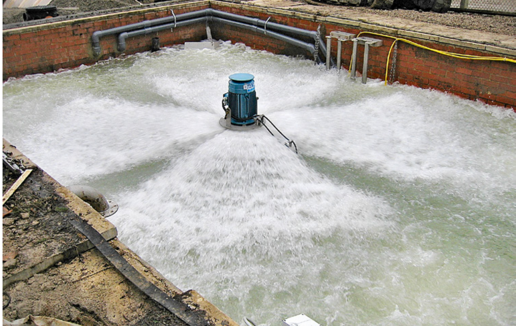
Durch das große Volumen des Belebungsbeckens bot sich der Einsatz des großen Belüftungsaggregats AQUASYSTEMS an. Das Foto zeigt den ersten Test nach dem Einbau mit befülltem Becken.
