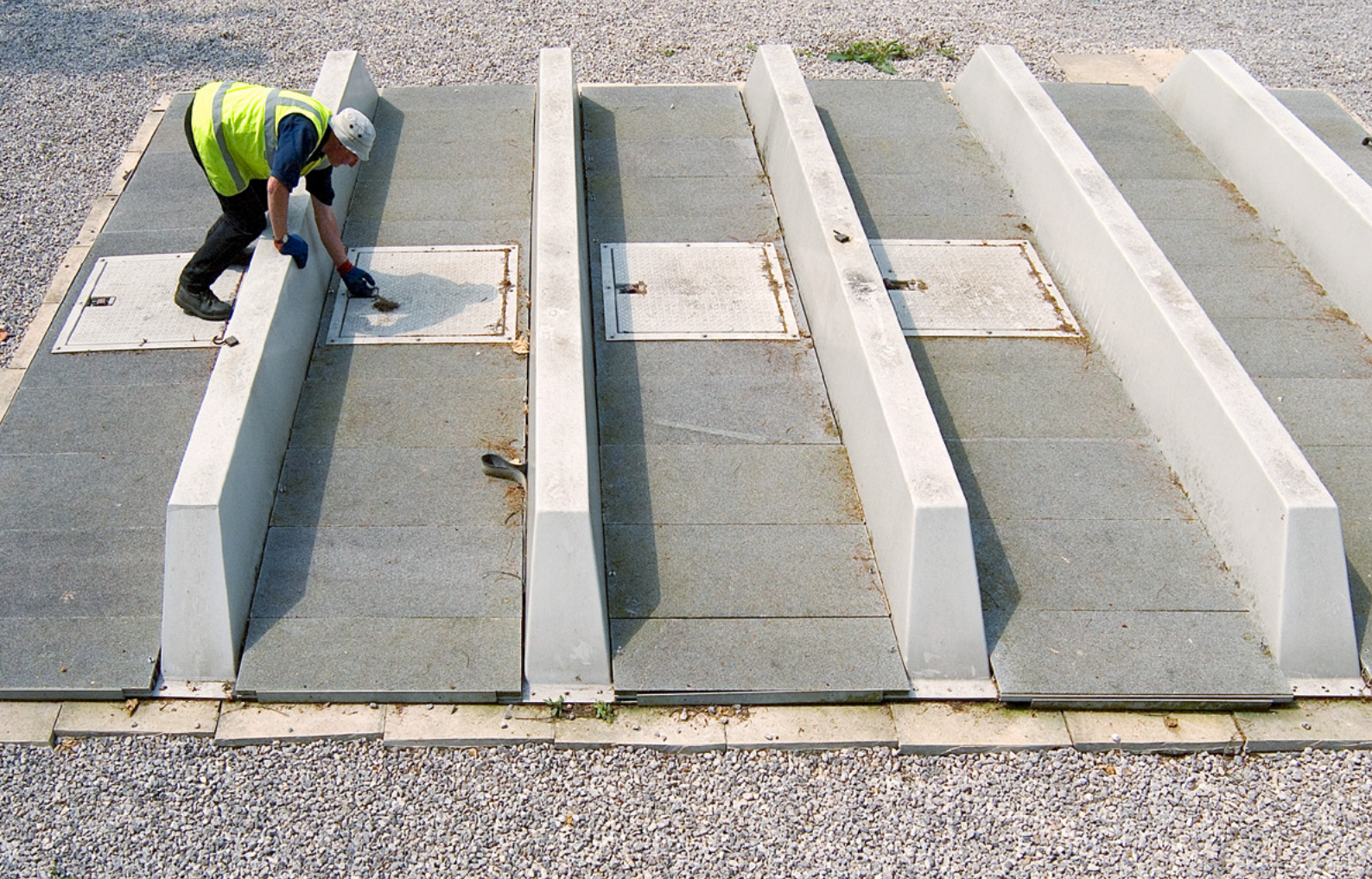
Durch das große Volumen des Belebungsbeckens bot sich der Einsatz des großen Belüftungsaggregats AQUASYSTEMS an. Das Foto zeigt den ersten Test nach dem Einbau mit befülltem Becken.
