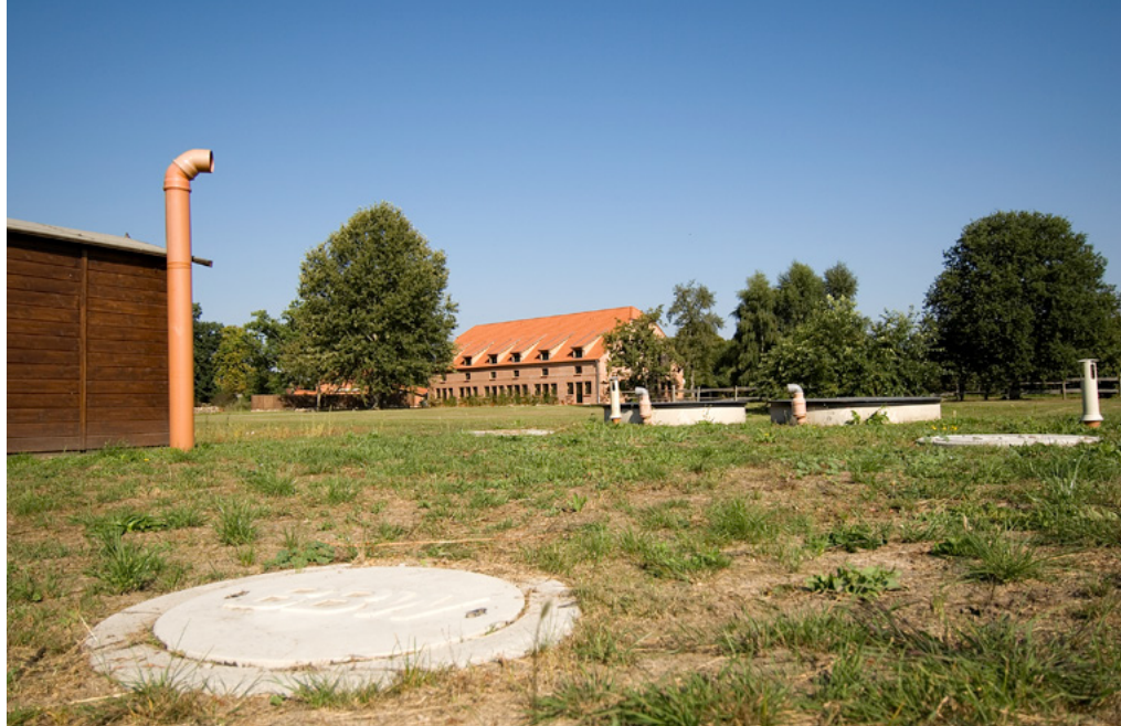
Auf der Koppel hinter dem Brauhaus-Hotel (im Hintergrund) befinden sich die 11 zur Kläranlage gehörenden Becken sowie das alte Gerätehäuschen, das heute die gesamte Anlagensteuerung beherbergt.
